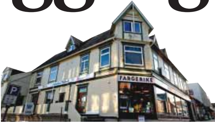
PÅ UBESTEMT TID: – Det jeg kan si, er at rivingen av Bakkeligården er utsatt på ubestemt tid, sa investor Hans Marius Brekke til HT i september.
